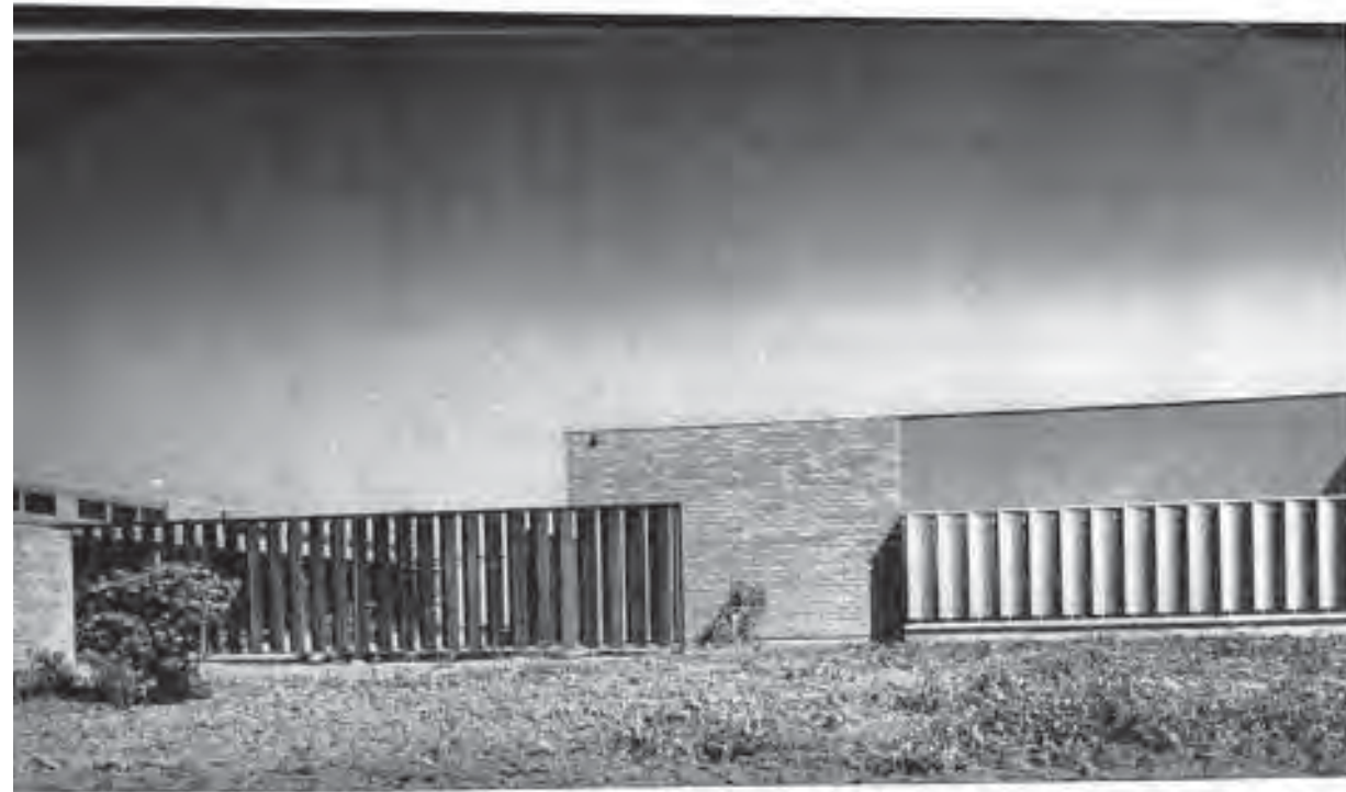
商業教育棟の北西側。左側は、樹にアクリル板でできた木製カーブ。日光と風とを調節する木製カーブ。 View of the northwest front of Merchandising Laboratory. Wood louvers give priority to the garden (left).
